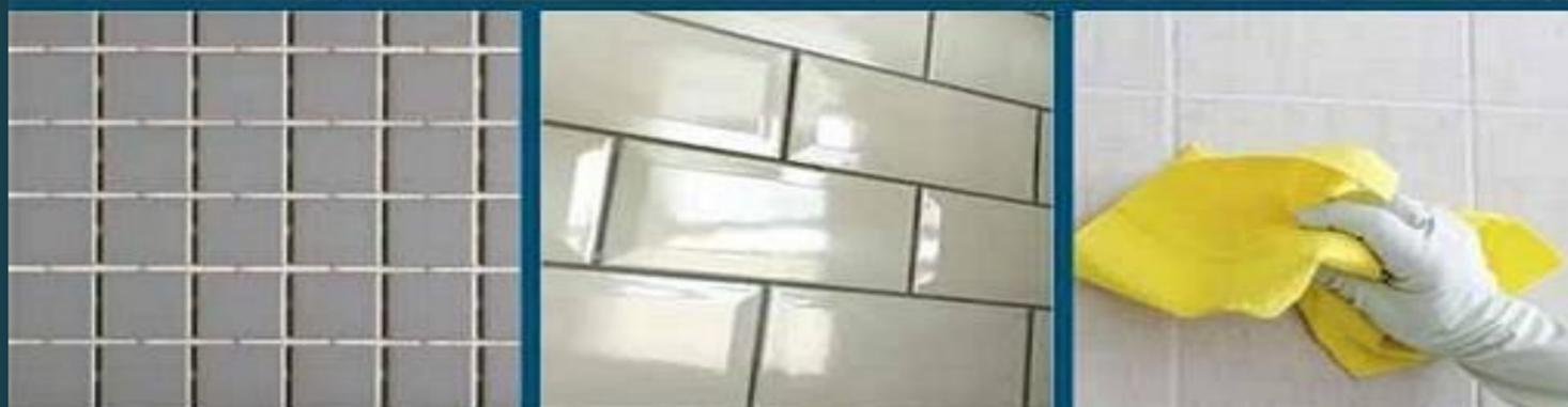
Após a aplicação do rejunte, espere cerca de 30 minutos até que o produto seque e inicie a limpeza com movimentos circulares, utilizando um pano ou esponja úmida, forçando a entrada do rejuntamento nas juntas e melhorando o acabamento. Aguarde de 30 a 45 minutos e finalize a limpeza apenas com um pano macio e seco;
